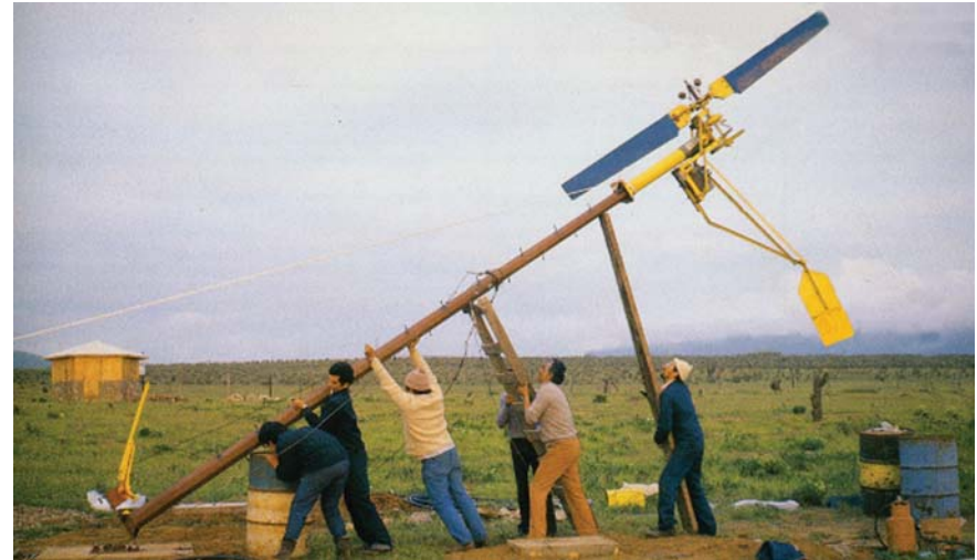
Figura IV.2.1: Aerogenerador de baja potencia (0,75kW) instalado en Comunidad Agrícola de Huentelauquén. Comuna de Canela. Región de Coquimbo. (Foto gentileza de ТЕКХНЕ)
